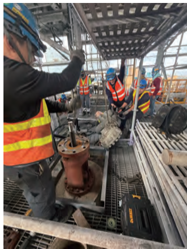
客戶：台中火力發電廠 工序：高壓焊口閘閥現場檢修
