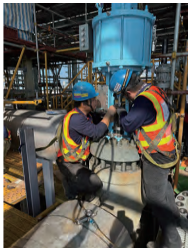
客戶：興達火力發電廠 工序：高壓控制閥驅動器現場檢修
